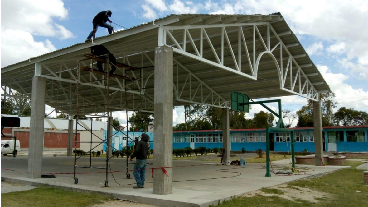
Construcción de techumbre escuela primaria El Ruano
