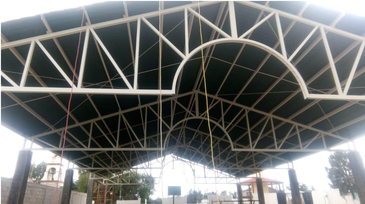
Construcción de aulas Esc. Preparatoria Oficial número 20 Cabecera Municipal
